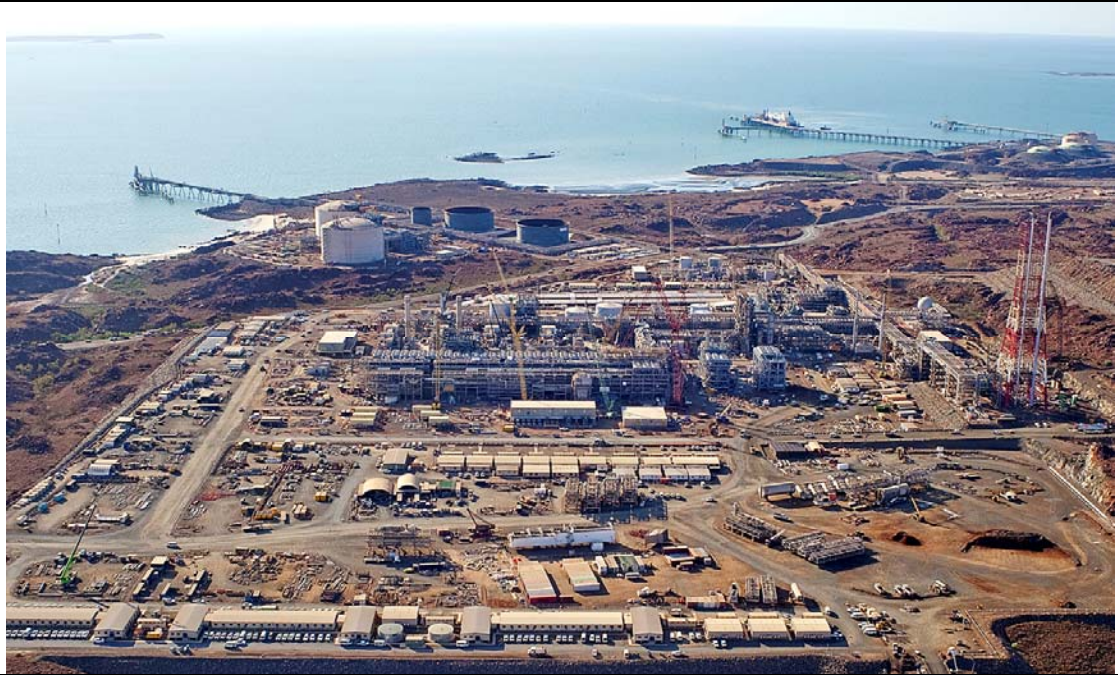
Plate 2: Pluto LNG Park, June 2010.
